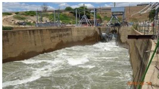
Figura: 1 - Descarregador de fundo da barragem de Massingir
