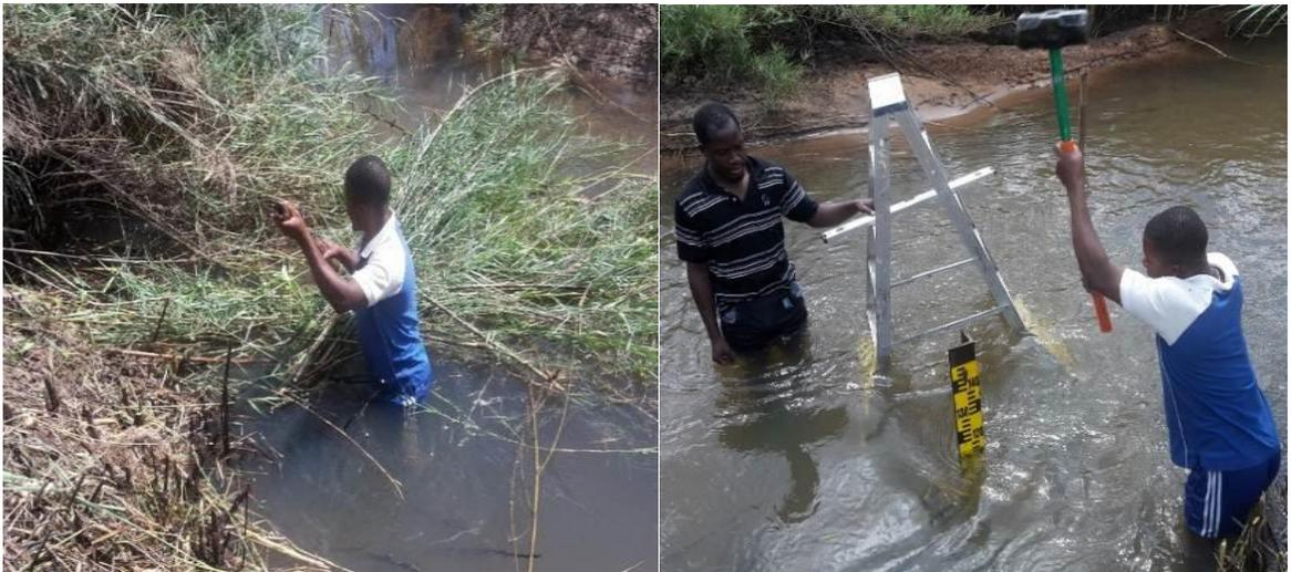
**Figura: 4** Imagens ilustrativas de actividades preparatórias para construção duma estação hidrométrica na bacia do Monapo, Nampula
