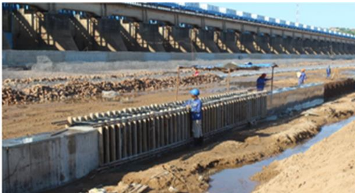
Figura: 1: Obras de reabilitação da barragem de Macarretane
