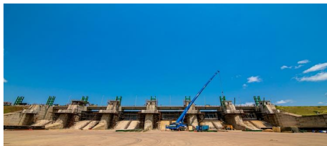
Figura 2: Vista do processo de montagem das comportas na barragem de Corrumana
