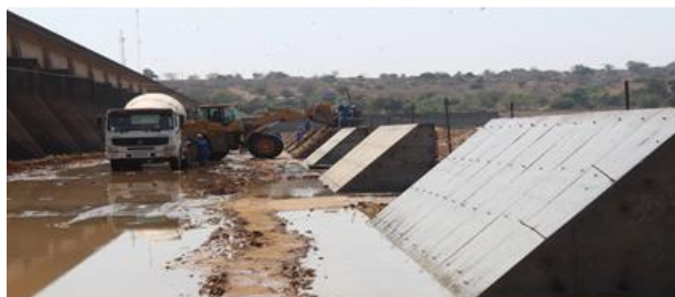
Figura 3: Sistema de dissipação de energia em bases de betão da barragem de Macarretane
