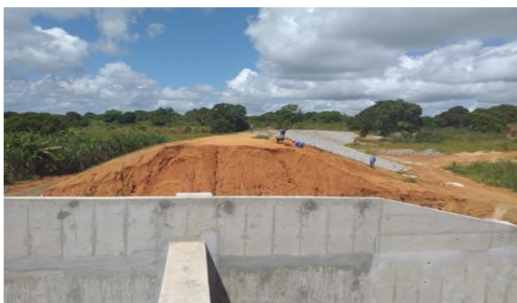
Figura 4: Obras de construção da represa de Nacopo, Meconta, Nampula
