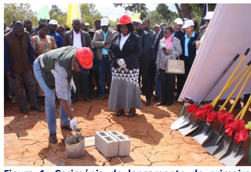
Figura 1: Cerimónia de lançamento da primeira pedra da barragem de Locumue
