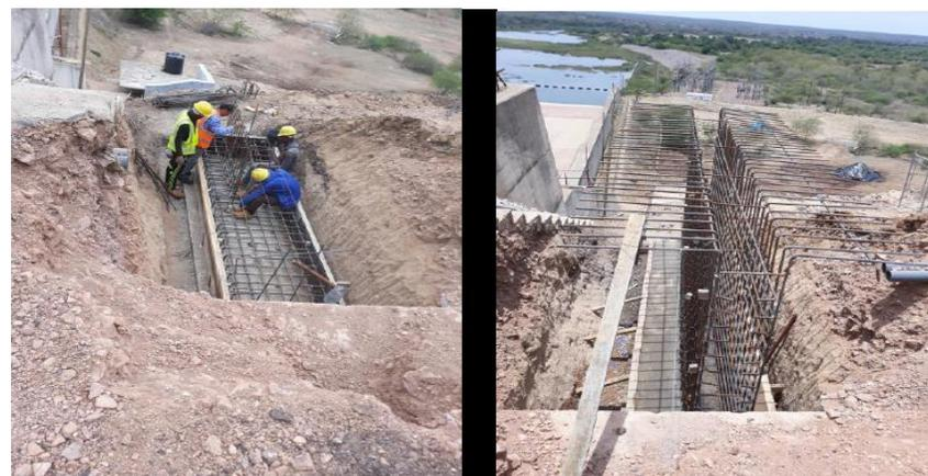
Preparativos para construção da base da laje de concreto na ampliação do coroamento
