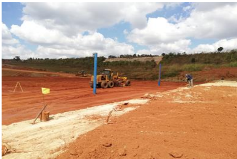
Execução do aterro do corpo da barragem
