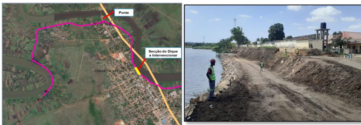
Fig. 5: Reabilitação do dique de Xai-Xai
