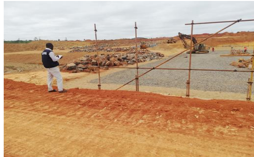
Execução do filtro
