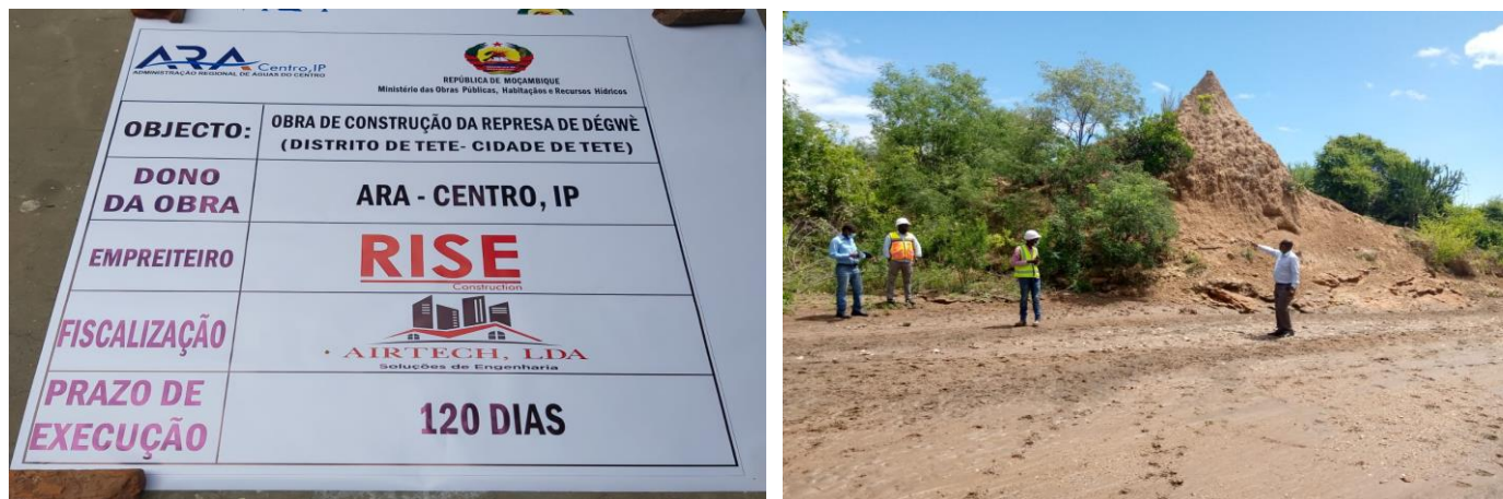
Fig. 2: Construção da represa de Dégwe /Tete
