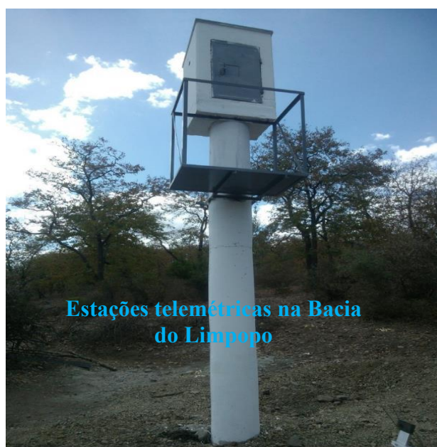
Foto 7: Estação telemétrica Bacia do Limpopo construída
