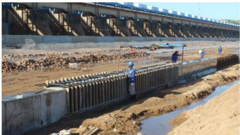
Foto 1: Reabilitação da Bacia de Dissipação da barragem – Edificação do muro
