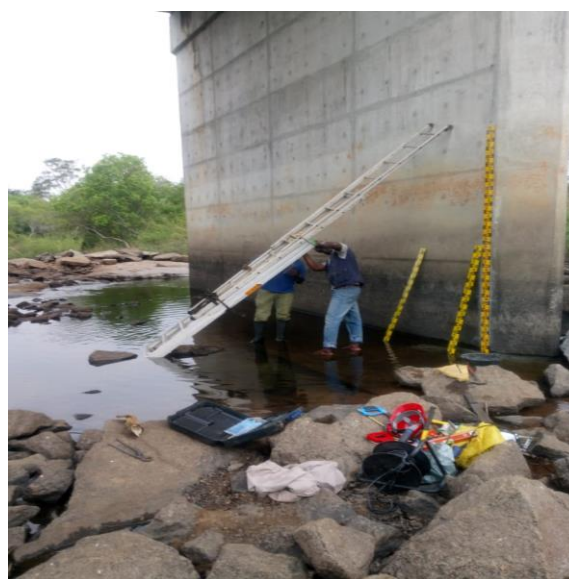
Foto 6: Estação E-216 Nungo/Marrupa Reabilitada
