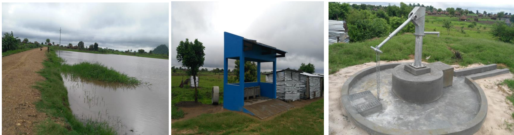
Foto 4: Represa de Nharichonga/Nhamatanda Construída
