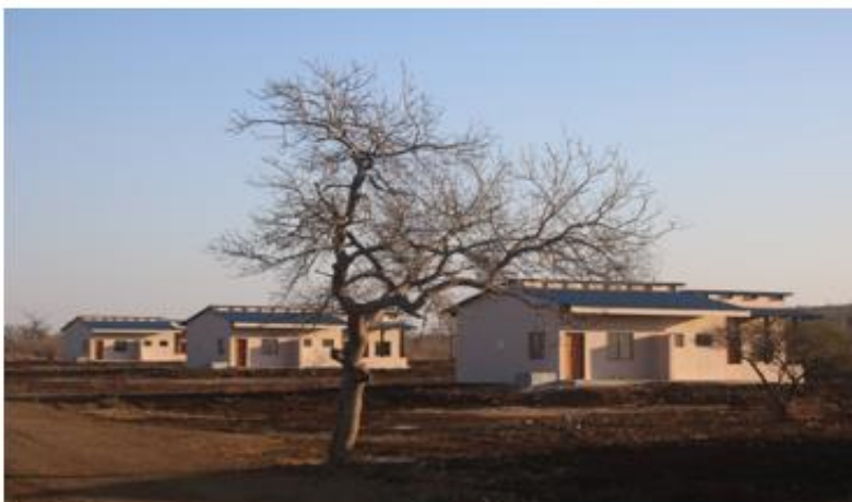
Foto 2: Montagem das peças fixas para as comportas da barragem e uma parte das casas de reassentamento
