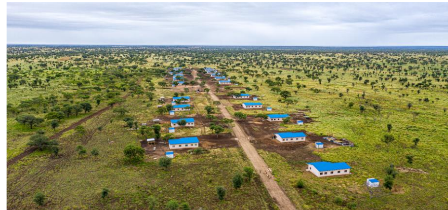
Fig.4: Casas construídas no âmbito de reassentamento das famílias (Corumana)
