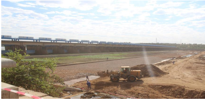
Fig.1: Reabilitação da bacia de dissipação (Macarretane)
