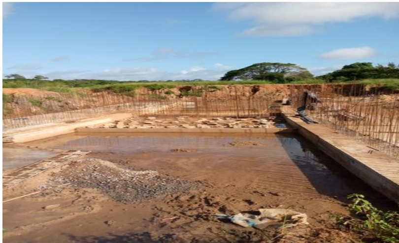
Fig.7: Obras de construção da represa de Mururoi/Liupo (Nampula)
