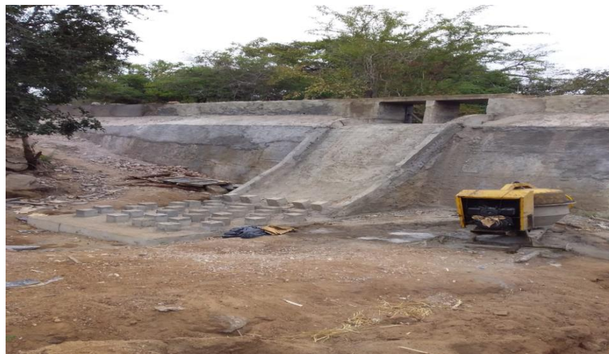
Fig.10: Obras de construção da represa de Cumbucane/Macossa (Manica)
