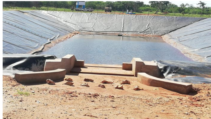
Fig.8: Reservatório escavado de Chiboa/Massinga (Inhambane)
