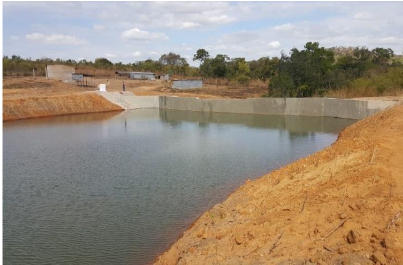
Fig.5: Obras de construção da represa de Mecucuti/Marrupa (Niassa)
