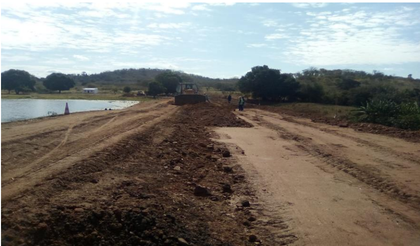
Fig.9: Obras de construção da represa de Nicanda/Montepuez (C.Delgado)
