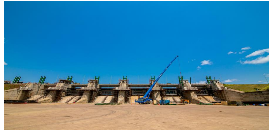
Fig. 3 Concluídas as obras de montagem das comportas (Corumana)
