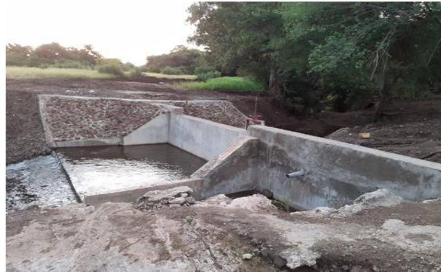
Fig.6: Obras de construção da represa de Thando/Maríngue (Sofala)
